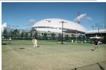
なみはやドーム (東和薬品RACTABドーム)
